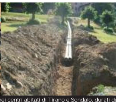
In queste immagini, alcune fasi degli scavi nei centri abitati di Tirano e Sondalo, durati due anni, per creare la rete di teleriscaldamento a biomasse, che si avvale del legno di manutenzione dei boschi e delle segherie valtellinesi.
