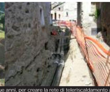
In queste immagini, alcune fasi degli scavi nei centri abitati di Tirano e Sondalo, durati due anni, per creare la rete di teleriscaldamento a biomasse, che si avvale del legno di manutenzione dei boschi e delle segherie valtellinesi.
