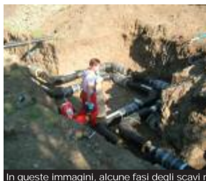
In queste immagini, alcune fasi degli scavi nei centri abitati di Tirano e Sondalo, durati due anni, per creare la rete di teleriscaldamento a biomasse, che si avvale del legno di manutenzione dei boschi e delle segherie valtellinesi.
