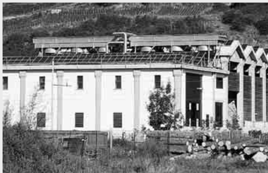
Ecco il tetto dell'impianto dopo la posa dei 400 pannelli fotovoltaici (Foto Lisignoli)
