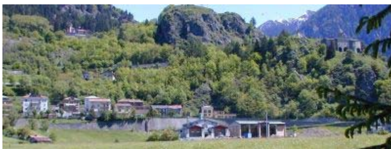
la centrale di Sondalo
