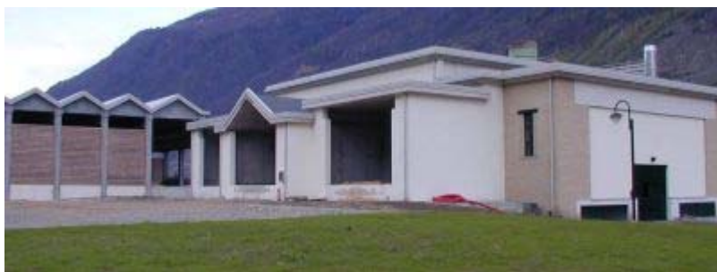
la centrale di Tirano
